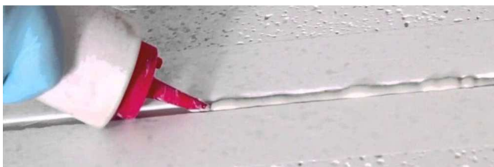
FIGURA 30. APLICAÇÃO DO REJUNTE COM A BISNAGA
