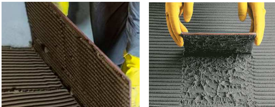
FIGURA 4. APLICAÇÃO DA ARGAMASSA EM COLAGEM DUPLA
