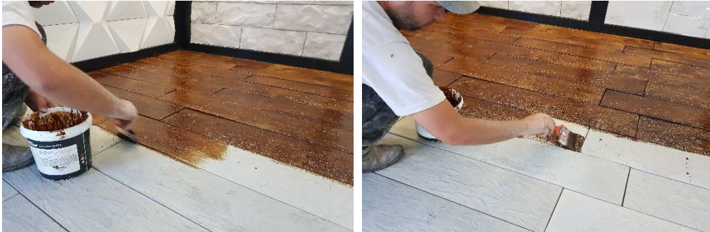
FIGURA 31. APLICAÇÃO DA RESINA
