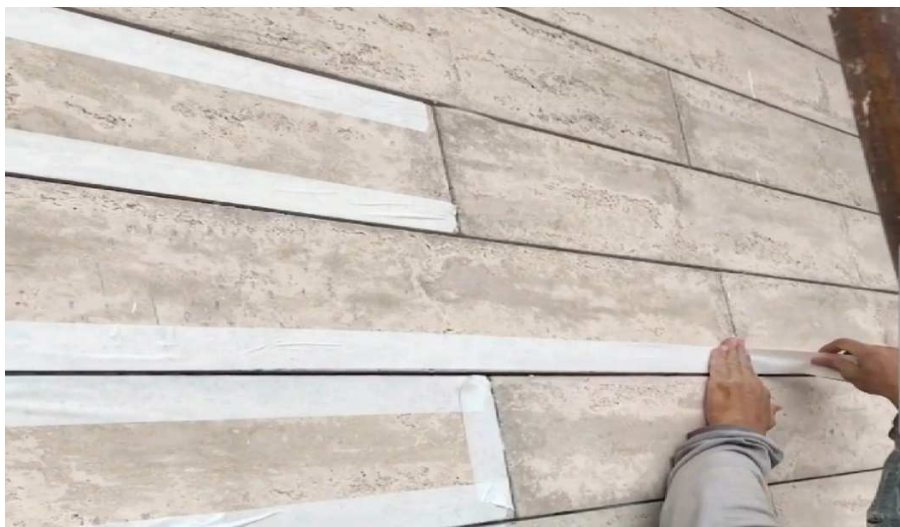
FIGURA 23. APLICAÇÃO DA FITA CREPE PARA REJUNTE INTERNO
