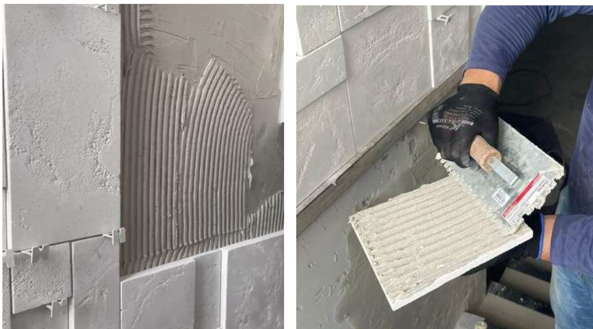
FIGURA 29. MODO DE APLICAÇÃO DA ARGAMASSA
